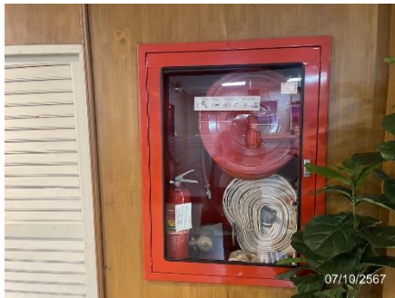
ตู้หัวฉีดน้ำดับเพลิงภายในอาคาร
